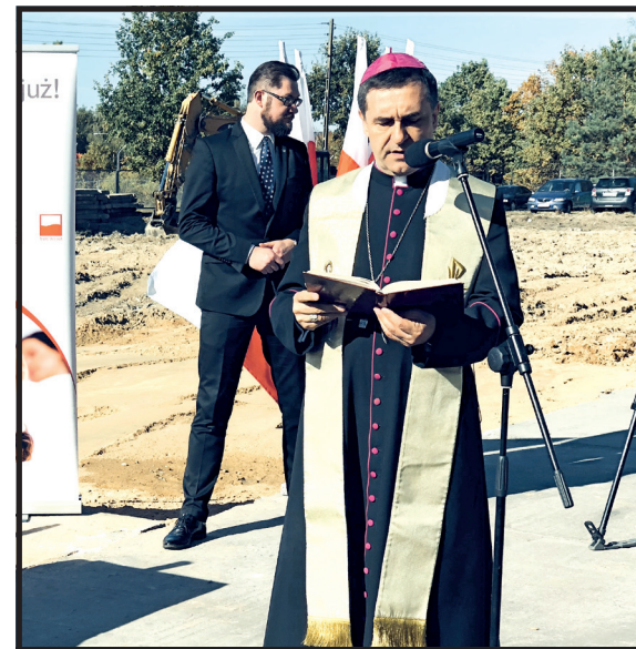
Biskup Piotr Sawczuk dokonuje poświęcenia placu budowy
