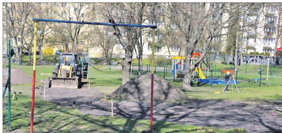
HS Budowa skateparku już trwa. Koszt inwestycji to 180 tys. zł
