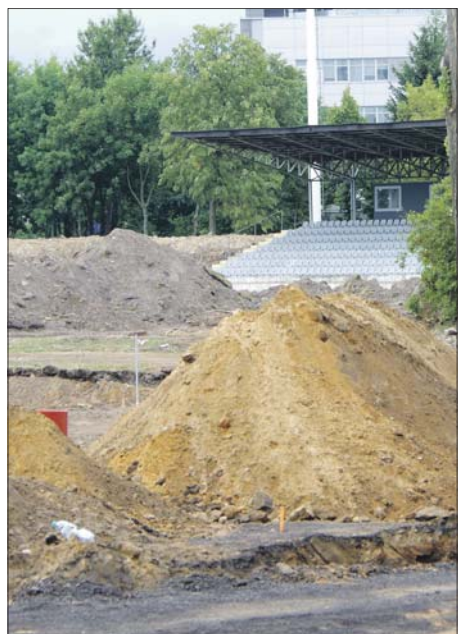
Rozgrzebany plac budowy zamiast stadionu...
