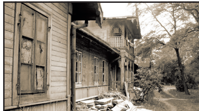
W tym budynku przy ul. Kolejowej 19 mieścił się Powiatowy Urząd Repatriacyjny (stan przed remontem)
