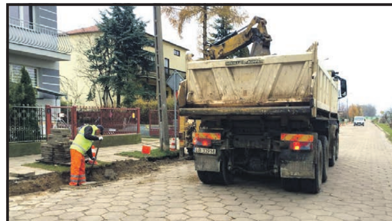
Na starą i wystuzoną trylinkę ul. Sworskiej zostanie położony asfalt
