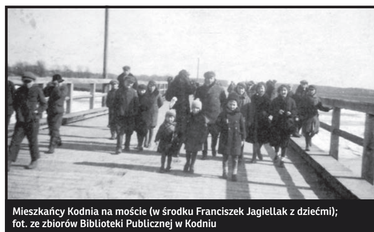
Budowa mostu na rzece Bug, po prawej katar; fot. ze zbiorów Biblioteki Publicznej w Kodniu
